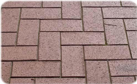
Pflaster mit Fugen
